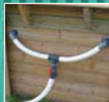
Tuyauterie semi-rigide diamètre 50 mm
